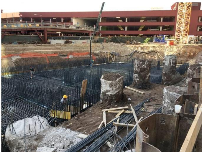
Fig. 14. Building ENI 2: detail of piles and raft foundation /Edificio ENI2 dettaglio pali e platea di fondazione.
