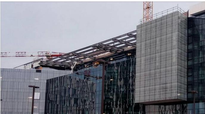
Fig. 18. Building ENI 4: steel cantilever beams /Edificio ENI4 zona a sbalzo con travi in acciaio.
