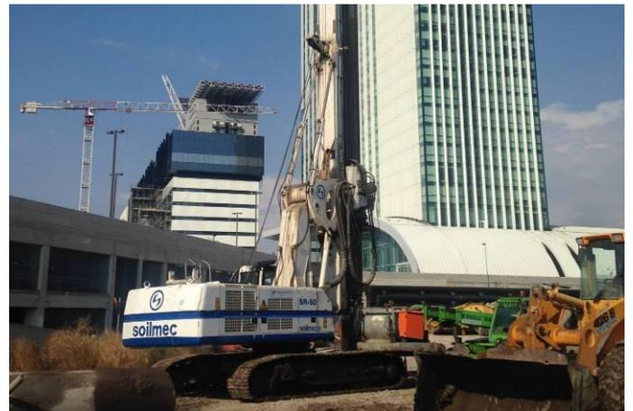
Fig. 28. Digging phase of foundation pile/fase di scavo di un palo di fondazione.
