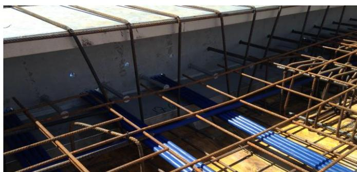
Fig. 19. Building ENI 4: connection detail between steel cantilever beams and post-tensioned slab /Edificio ENI4 dettaglio di connessione solaio post-teso/travi in acciaio.
