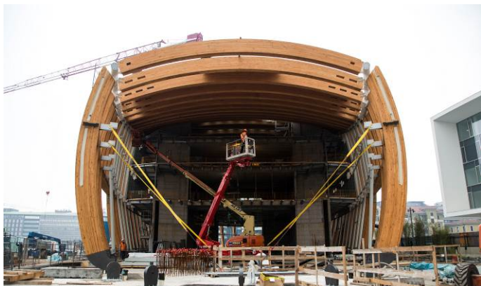
Figure 11. Detail of iperstatics arcs used in open space / dettaglio archi iperstatici utilizzati nell'open space
