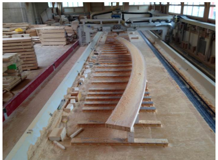
Figure 23: Toning phase of timber laminated column / dettaglio di tornitura di una colonna in legno lamellare.
