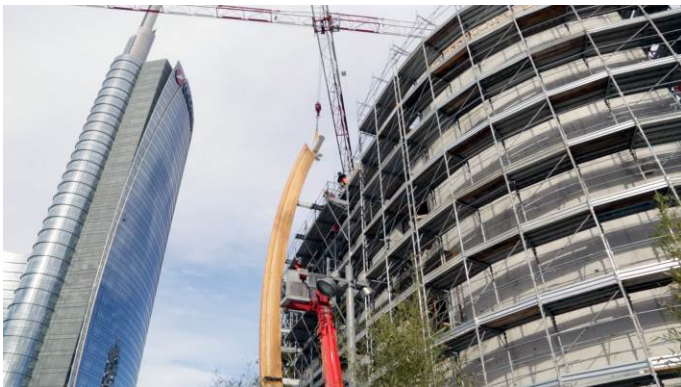
Figure 25: installation phase of first column / varo della prima colonna.
