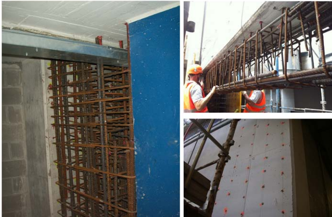
Figure 20: Details of strengthening concrete / dettaglio dei rinforzi in calcestruzzo eseguiti nei piani interrati del Podio.
