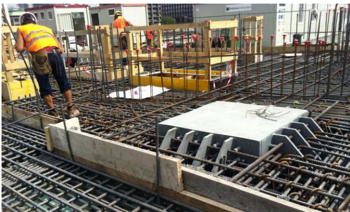
Figure 21: Details of construction foundation phase / dettaglio di realizzazione della nuova platea
