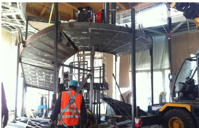
Figure 15. Detail of helicoidal steel stair/ dettaglio della scala elicoidale in acciaio
