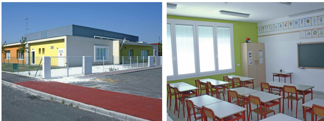
Fig. 1 - La scuola di Mortizzuolo a Mirandola in muratura armata POROTON®, indenne dopo il sisma del 2012.
