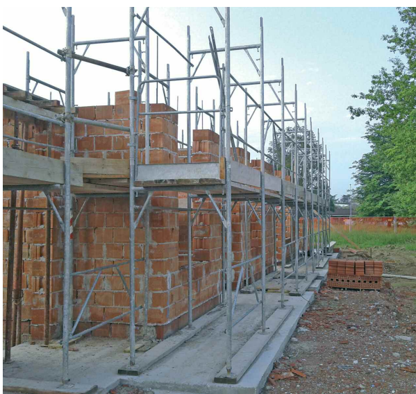
Fig. 12 - Fasi di realizzazione della muratura armata POROTON®.
