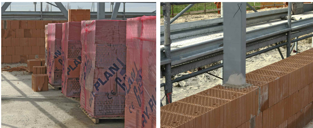
Fig. 9 - Fasi realizzative della muratura rettificata POROTON® PLAN.
