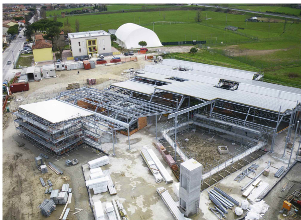
Fig. 6 (a sx) - Vista generale di fasi realizzative di cantiere.
