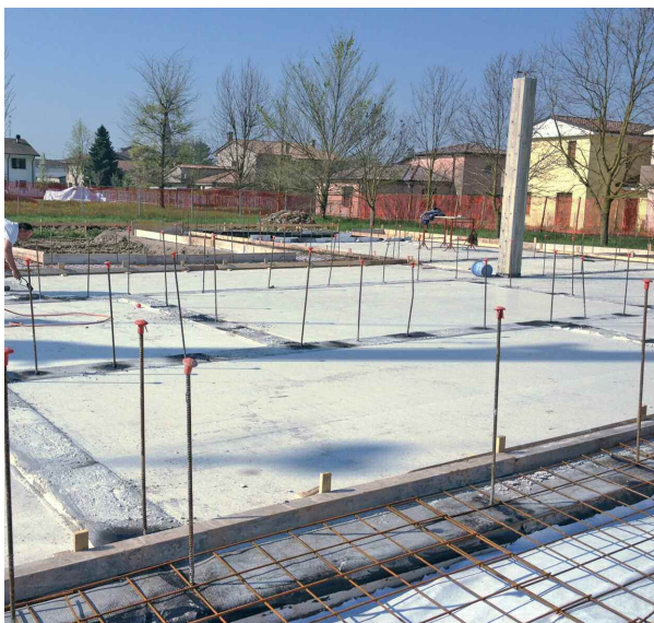
Fig. 11 - Fondazioni a travi rovesce con chiamate delle armature verticali già inglobate nel getto ed impermeabilizzazione.
