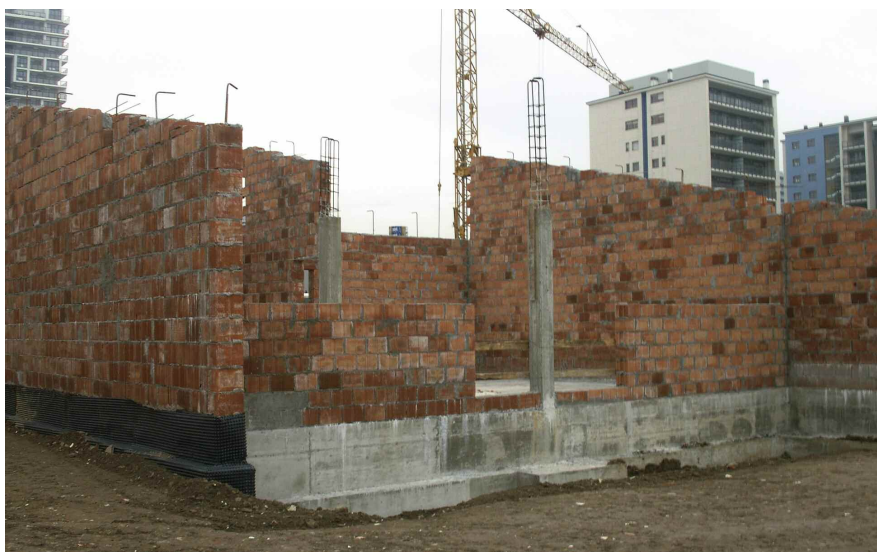
Fig. 2 - Il cantiere con in primo piano le strutture in muratura portante.
