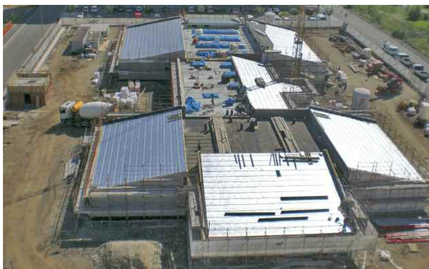
Fig. 3 - Vista dall'alto del complesso scolastico in costruzione.
