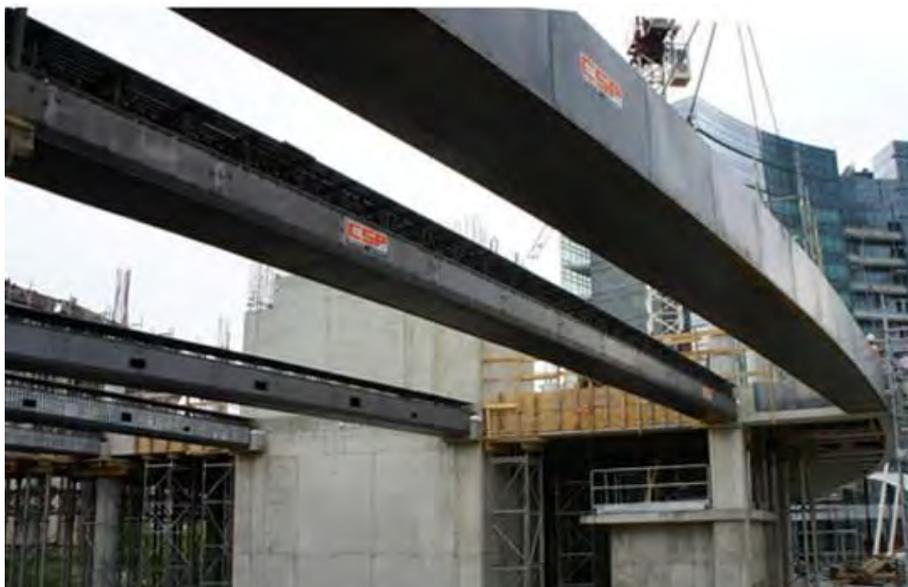
**Figura 27.** Zona collegamento E1-E2: travi PREM autoportanti con fondello e sponde in lamierino
