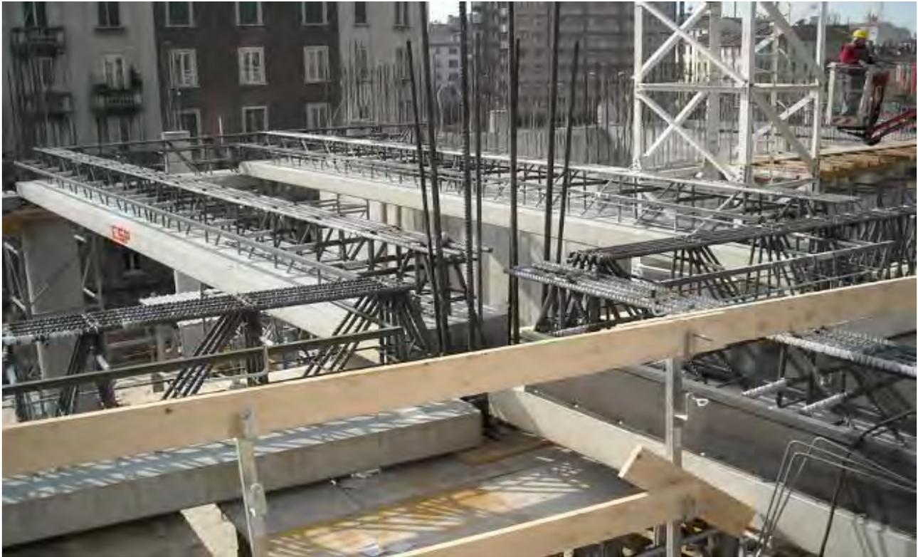
**Figura 23.** *Nodo trave-pilastro a quattro vie*
