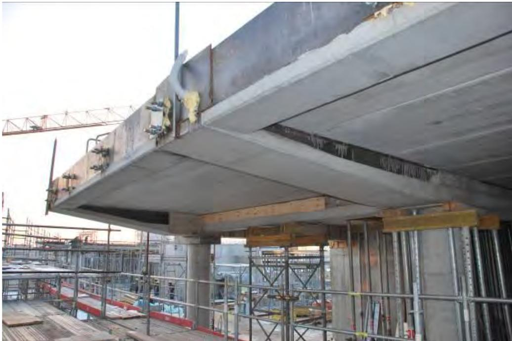
**Figura 25.** Vista intradosso elementi PREM con rastremazione della sezione: solaio di copertura. L5 (+155.50)
