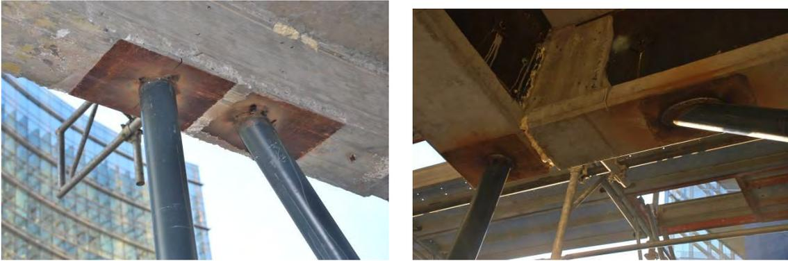
**Figure 20 e 21. Carpenteria e travi PREM**
