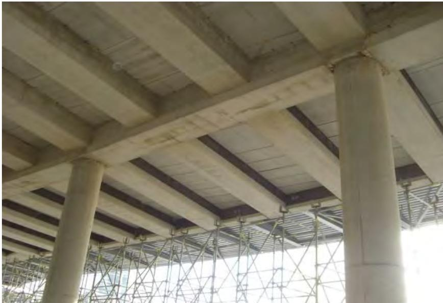
**Figura 26.** Orditura delle travi PREM dello sbalzo al livello copertura, L5 (+155.50)
