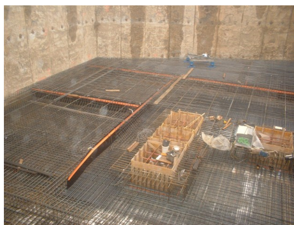
Fig. 16 - 17 : pannelli di prefessurazione posizionati nello spessore della platea fondazionale
