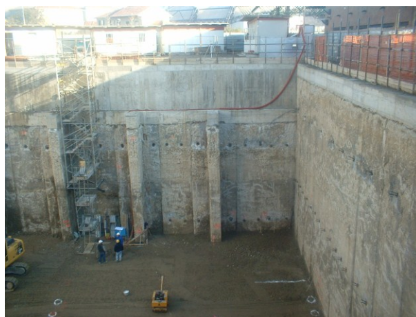
Fig. 10 e 11 : viste delle paratie con sezione a "T"
