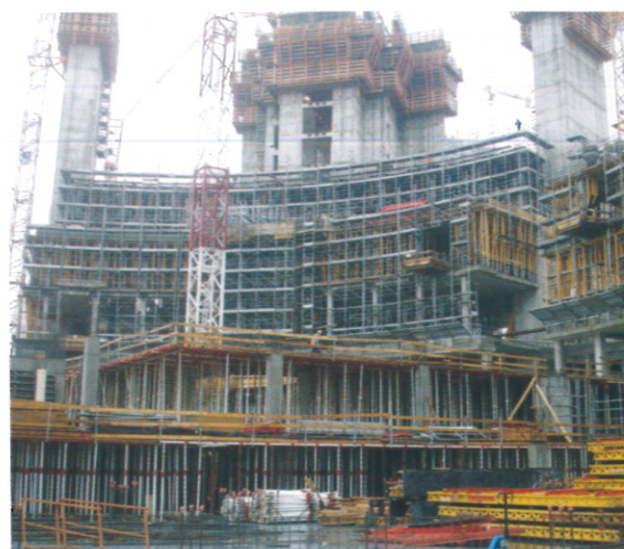
Torre B - Fase di cantiere.
