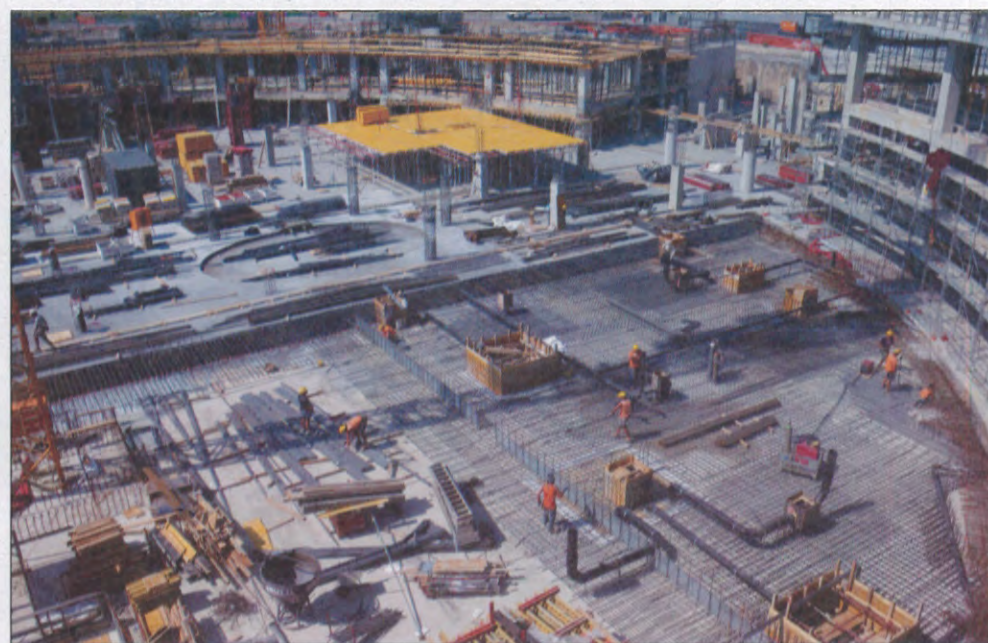
Stesura dell'armatura nella platea di fondazione
