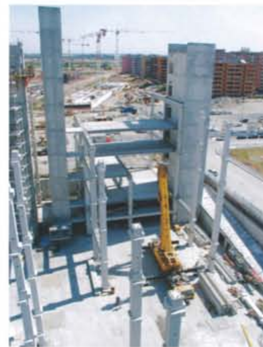
Vista pilastri e muri vani scala.
