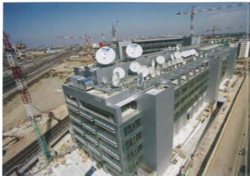
Antenne di emissione segnale.
