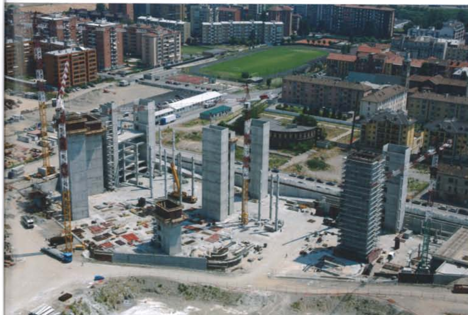
Esecuzione strutture verticali in opera
