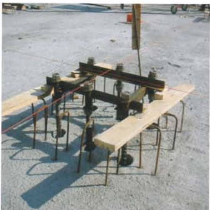
Inserti di collegamento nella platea
