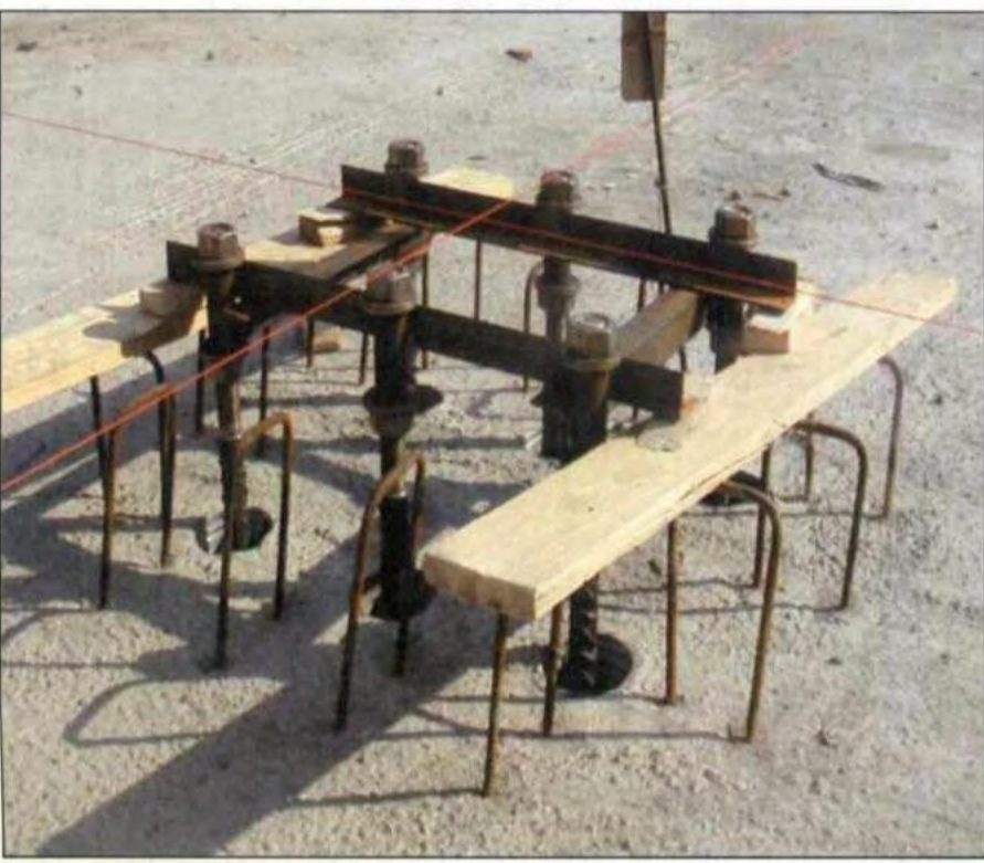
Inserti per collegamento pilastri nella platea
