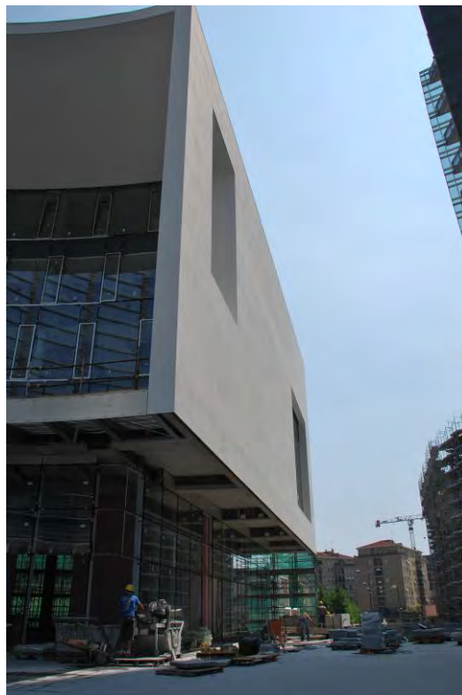
Figura 31. Vista d'insieme della facciata est
