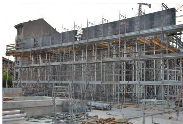
Figura 28. Fase di montaggio dei conci della trave parete ovest. Liv. 1
