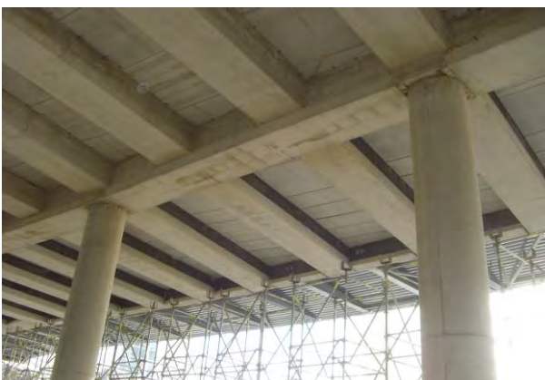
Figura 26. Orditura delle travi PREM dello sbalzo al livello copertura, L5 (+155.50)
