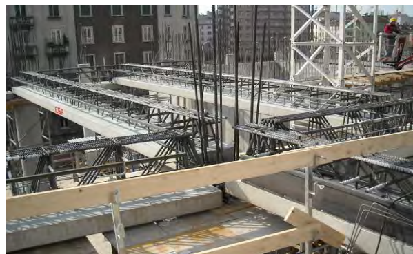
Figura 23. Nodo trave-pilastro a quattro vie
