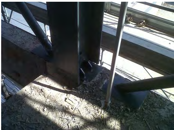
Figura 29. Piastre predisposte nelle travi PREM per il fissaggio dei profilati in carpenteria metallica
