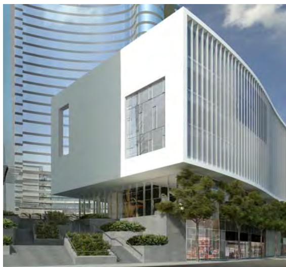
Figura 17. Testata edificio E1
