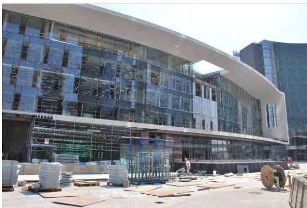
Figura 30. Vista d'insieme della facciata nord interessata dagli sbalzi di notevole luce.
